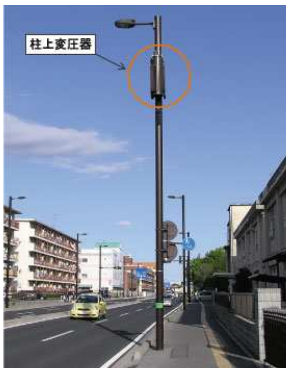
図18 ソフト地中化方式による無電柱化のイメージ
