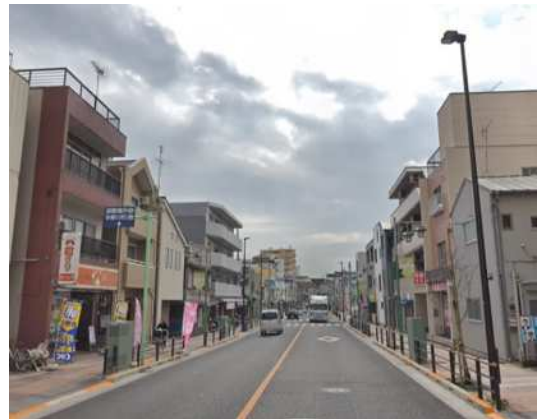
図4 補助第44号線上池台付近
