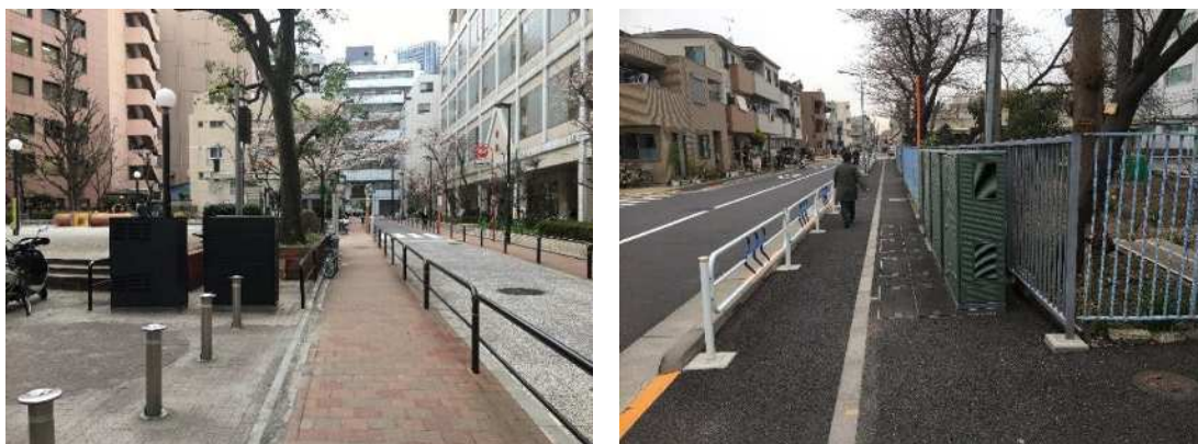
図6 学校や公園等の公共施設を活用して地上機器を設置した例
