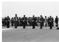
羽田新A滑走路完成(昭和63年)
