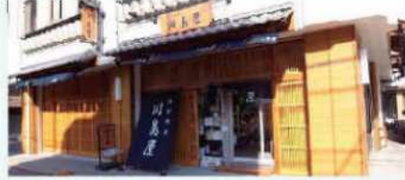
○店先に、開口を設け店内の様子や活動を見えるようにしています。隠す部分は格子戸などを用いて表情を豊かにしています。(大森本町 C5)
