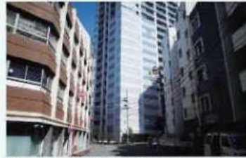
○タワー式駐車設備を集合住宅棟に一体に組み込んでいます。(大森北C4)
