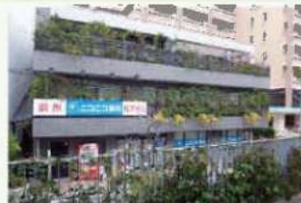
○植栽スペースを確保しにくい商店街では軒上やバルコニーでの緑化も効果的です。(北千束 D2)
