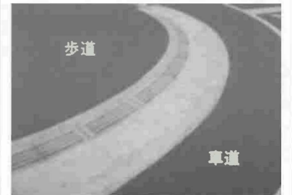
▲歩行者等が安全に通行できるように歩車境界の段差解消に配慮されている。(千代田区)
