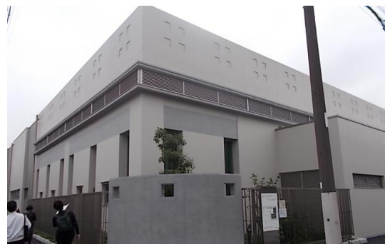
大森第七中学校 竣工後現場調査
