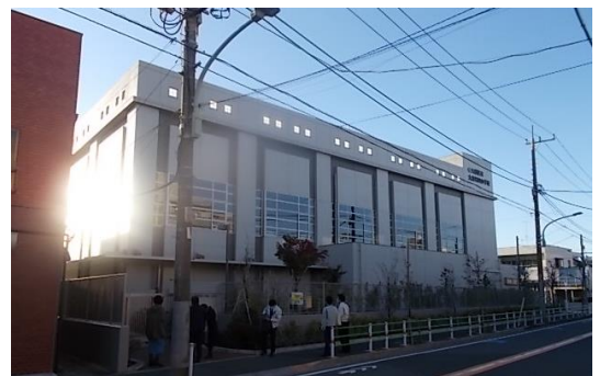
大森第四小学校 竣工後現場調査
