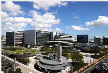
ヤマトグループ 羽田クロノゲート [羽田旭町11-1]
