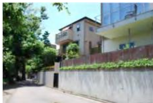
公園側にバルコニーや出窓を設けて、木質系の塀や植栽とともに親しみやすい表情をつくっています。（南千束 B1）
