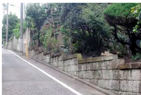
大谷石の階段状の擁壁が、坂道の表情をつくっています。(南千束 D6)
