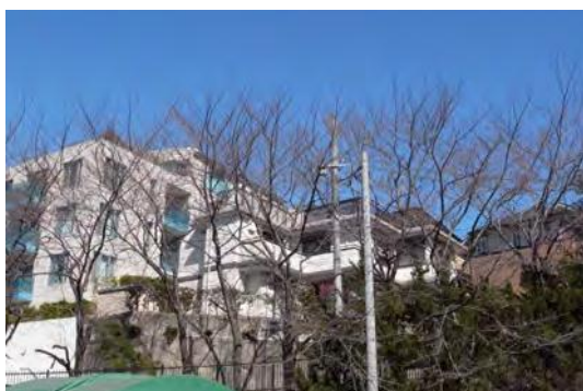
樹木の高さや周辺の屋根との調和をとり、上部も後退しています。(B1)
