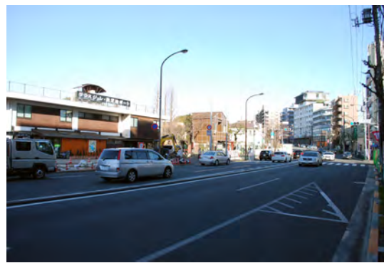
歩道橋撤去（平成29年1月）後の中原街道沿道（洗足池駅前）
