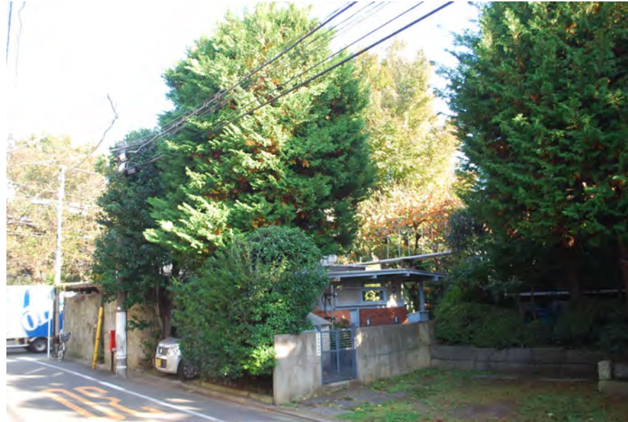
私の家（清家清白邸）敷地北側道路からの全景 （平成 29 年 11 月撮影）
