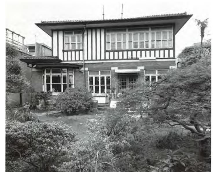
庭からの建物南側全景 （出典：大田区の文化財第 27 集 大田区の近代建築-住宅編 1-）
