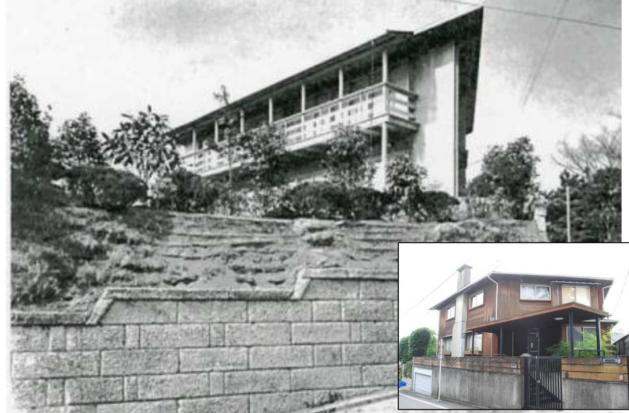
伊藤家住宅主屋（左写真：建物南側からの外観（出典：建築文化 1964年4月）、右写真：建物北側からの外観）
