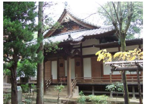
洗足池のほとりにある 国の有形登録文化財である妙福寺祖師堂 (旧七面大明神堂)
