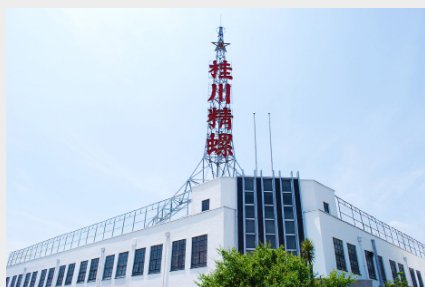
桂川精螺の工場建築 [矢口3-24-1]
