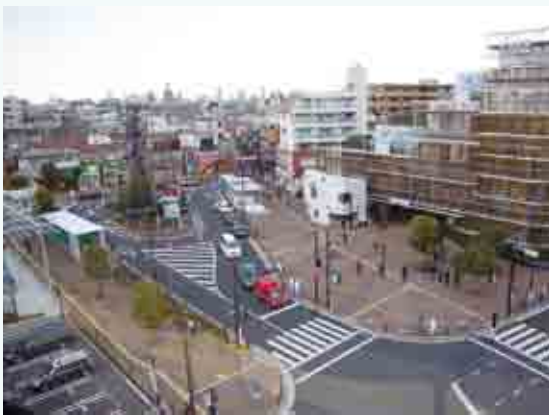
○駅前広場に向けて駅や店舗等が開放的な顔をむけた建て方になっています。(北千束 C1)
