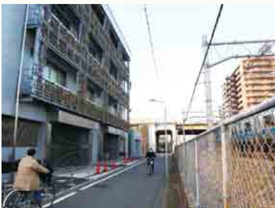
○【鉄道】に面する壁面に緑化格子を設けています。(中央 D1)
