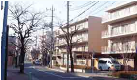
○周辺の街並みと調和するように分棟してスリットを設けた建て方にしています。(西蒲田 C2)
