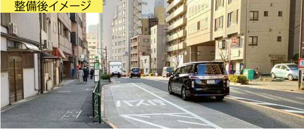
<品川区東大井5丁目付近>整備済区間
