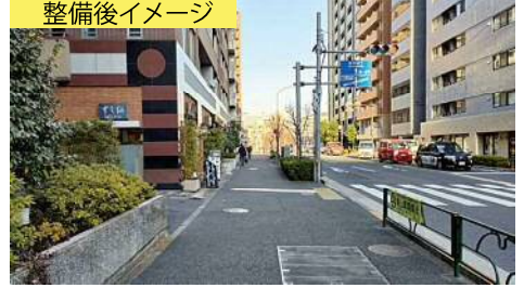
<品川区東大井5丁目付近>整備済区間
