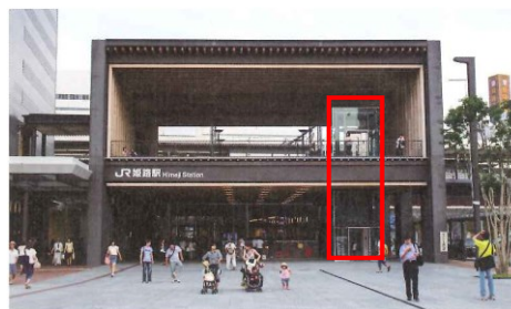
バリアフリーが確保された歩行者空間（フラットな歩行者空間、エスカレーター）（姫路駅）
