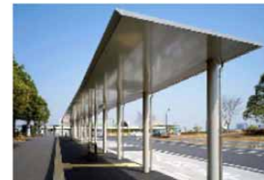
主要構造材：鉄骨、 屋根材：アルミ型材
