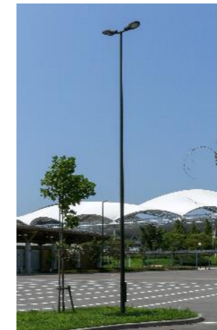
車道照明(H=約8.0m)
