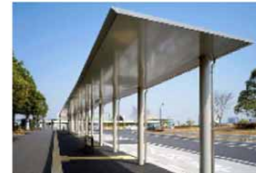
主要構造材：鉄骨、 屋根材：アルミ型材
