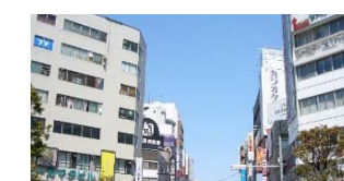
駅前広場から駅街路 3 号線をみる
