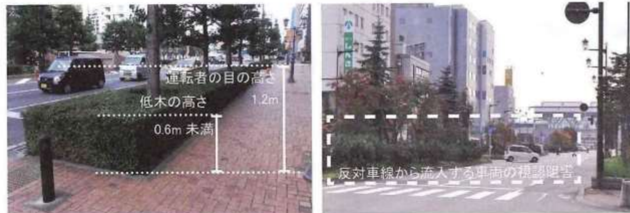
写真 2-2-18 運転者の視線と低木の高さ
