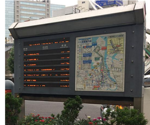
既設バス電光掲示板
