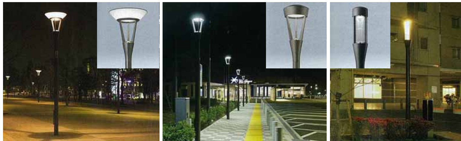
歩行者動線に合わせた統一的な街路灯の設置
