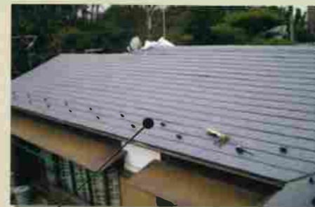
屋根の改修工事と合わせて耐震化の効果があります。
