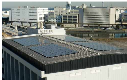
区立羽田中学校の体育館屋根に設置している太陽光発電*システム (50kW)
