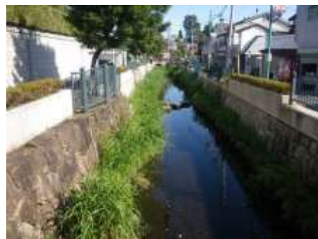
上流端の植生がある水際 石積み護岸がみられる
