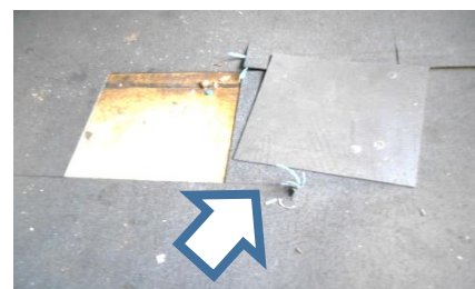
床材（ビニール床タイル）
