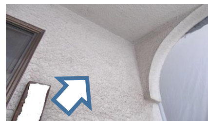
外壁（仕上塗材）
