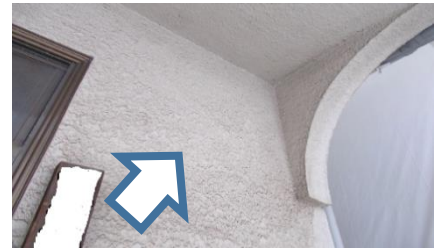
外壁（仕上塗材）
