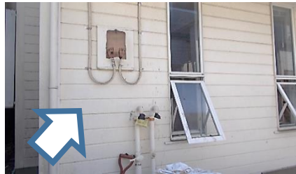
外壁（サイディング）
