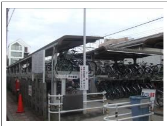
東急武蔵新田自転車等駐車場
