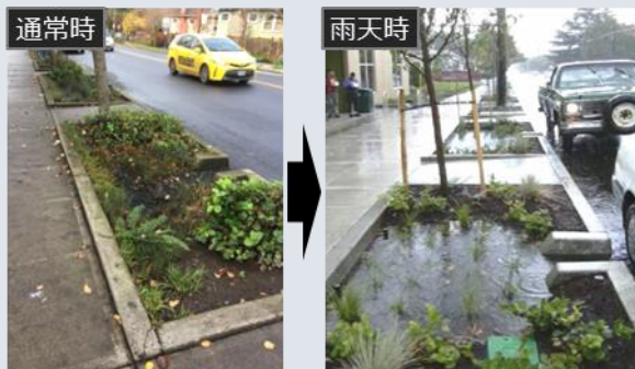
▲緑溝（バイオスウェイル）（ポートランド 米国） 【出典：グリーンインフラ総研】
