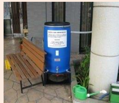
昇降口付近での雨水タンクの設置例（茅ヶ崎市）
