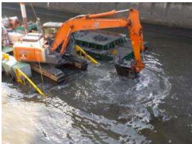
【32】 河床整正工事
