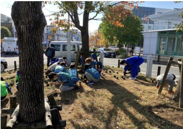
【令和4年11月19日 大岡山駅前ロータリーでのシバザクラ苗植え付け作業】
