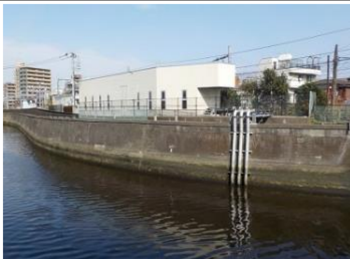
【33】高濃度酸素水浄化施設
