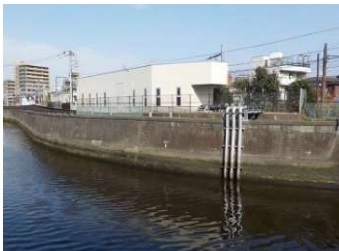
【33】高濃度酸素水浄化施設
