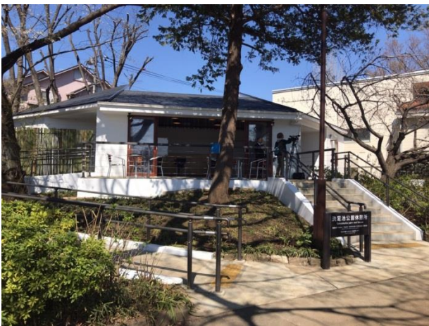
【13】洗足池公園休憩所
