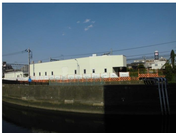
【32】 高濃度酸素水浄化施設 (浄化施設新築工事)
