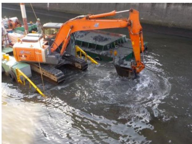
【32】 河床整正工事
