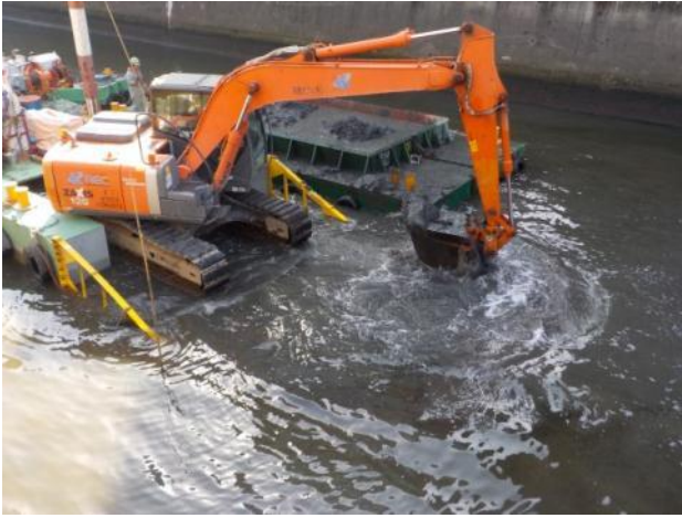
【32】河床整正工事
