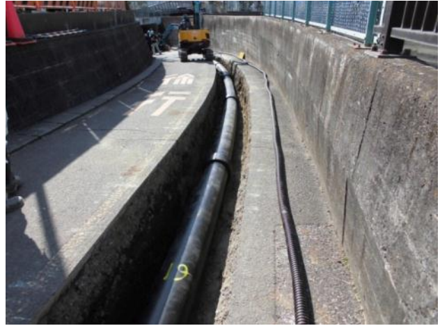
【32】高濃度酸素水浄化施設 (送水管布設工事)
