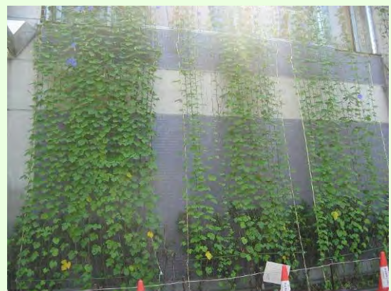
緑のカーテン施工例（糞谷・羽田地域庁舎分室）
