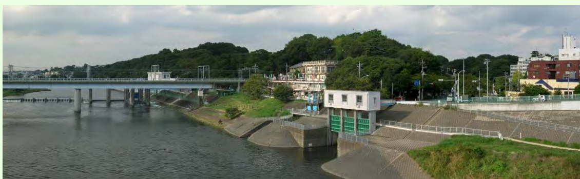
多摩川台公園、田園調布せせらぎ公園付近
