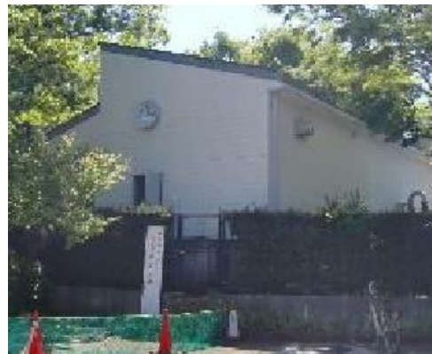
水質浄化施設
