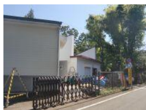
⑤ 水質浄化施設
