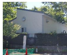
水質浄化施設
