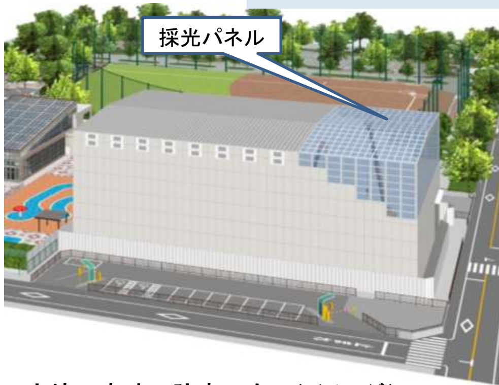
立坑工事時の防音ハウス(イメージ)
