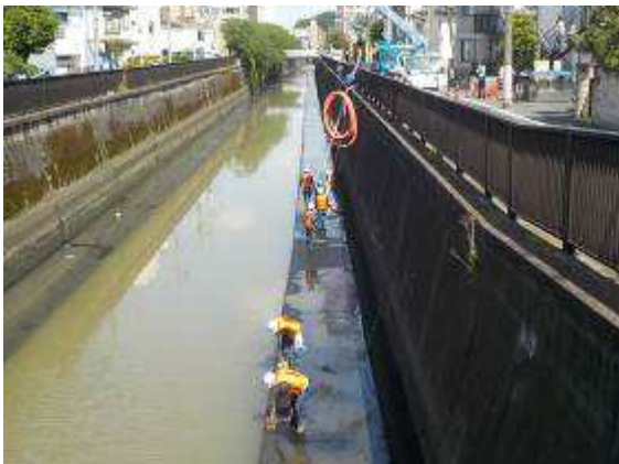
写真 2.6 施工状況写真（遠景）
