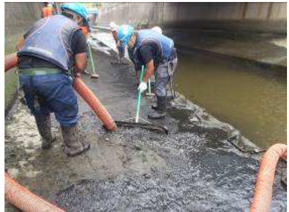
写真 2.7 施工状況写真（近景）
