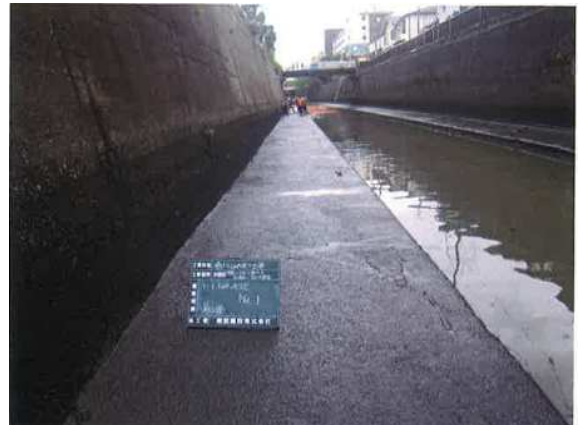
写真 2.9 施工後写真（一本橋上流側）
