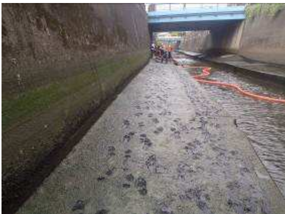
写真 2.8 施工前写真（一本橋上流側）
