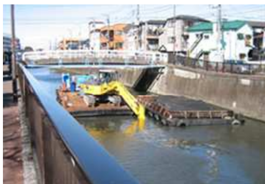
写真 2.4 バックホウによる浚渫状況
