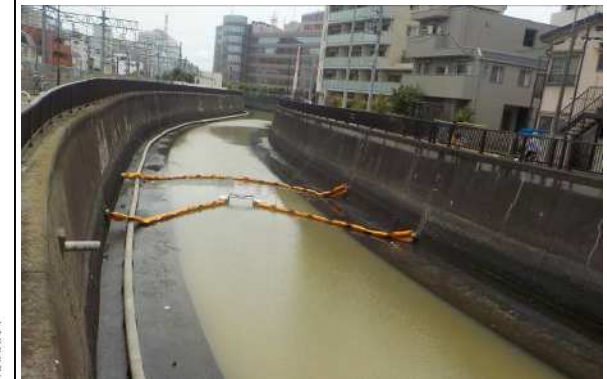
写真 2.2 放流管配管状況
