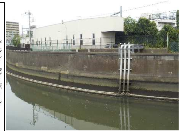
写真 2.1 高濃度酸素水浄化施設全景
