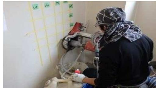
2.採取した後の鉄筋コンクリートの壁(この部分は補修します)と、採取したコンクリートコアの写真です。採取したコアは検査をします。
