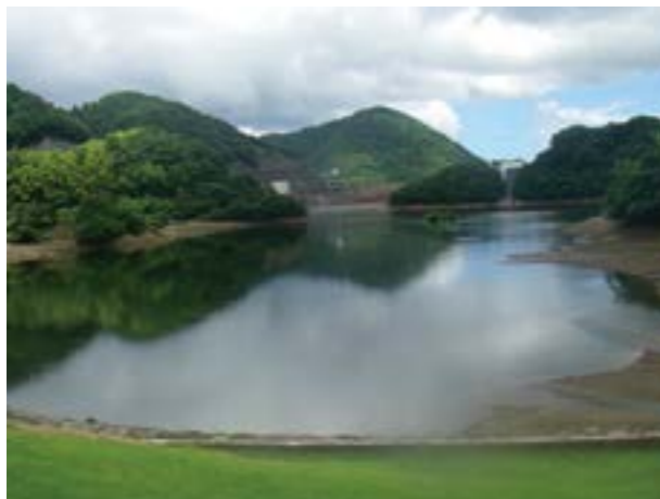
▲松川湖 中伊豆のバイパスの途中に奥野ダム（松川湖）があります。
