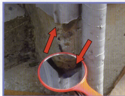
角は特に隙間がしやすい (鏡の中に隙間が見えます)
