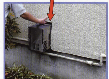
バランス釜排気口の上部
