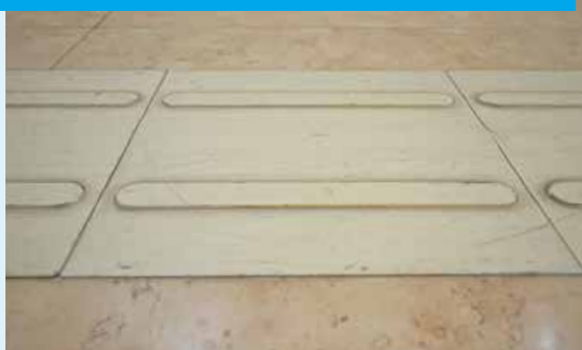
屋内用に作成した点字ブロック(本庁舎2階)
