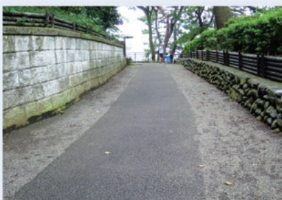
ベビーカーや車いすの通行のため砂利道の中央のみアスファルト舗装
