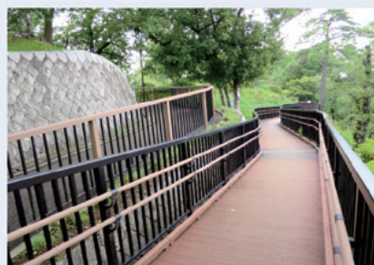
緩やかな勾配の木道のスロープ
