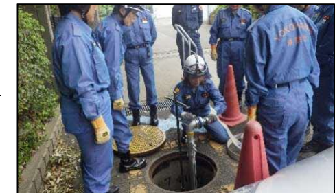
【スタンドパイプ取扱訓練の様子】
