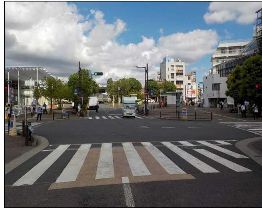
無電柱化整備後 (大岡山駅前広場)
