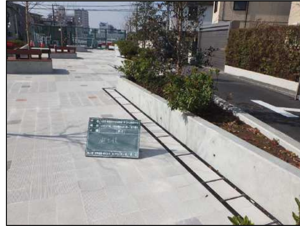
排水施設工事
