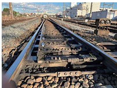
レールの尖った部分が左右に転換し、列車の進行方向を左右します。
